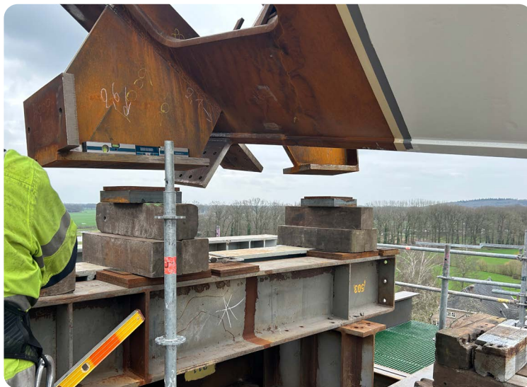
Figuur 13: Foto vanaf het montageplatform, waarbij de steunvoeten in positie werden gebracht. Op het montageplatform waren vulstukken aanwezig om het boogbeen op de gewenste hoogte te plaatsen (bron: staalbouwer).
