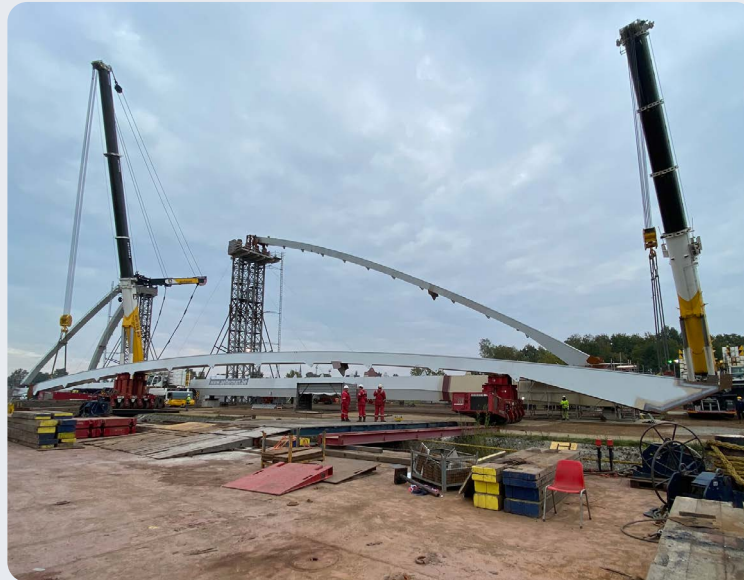
Figuur 23: Montage boogbrug Beringen 2020 (bron: staalbouwer).
