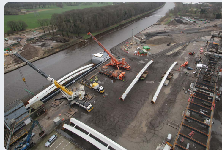
Figuur 28: Proces van ontschepen boogbenen, het eerste boogbeen ligt op een transportmodule bij het brugdek (bron: hoofdaannemer).
