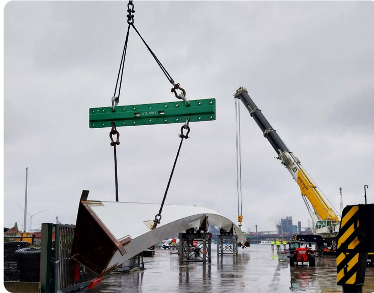
Figuur 8: Foto van een boogbeen op de kade bij de fabriek van de staalbouwer in Gent. In het midden van de boog zijn twee transportzadels zichtbaar, daar ligt de boog in tijdens transport. Aan het verre eind van het boogbeen zijn de twee roestkleurige steunvoeten zichtbaar. Aan de voorzijde zijn de vier tijdelijke flenzen voor montage aan het brugdek zichtbaar. De montage zou gebeuren met koppelplaten, waarvan er een aantal zichtbaar is (rood) (bron: hijsbedrijf).
