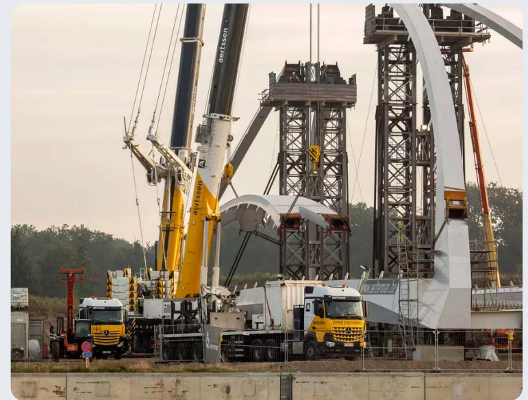
Figuur 24: Montage boogbrug Schoten 2021-2022 (bron: hijsbedrijf).
