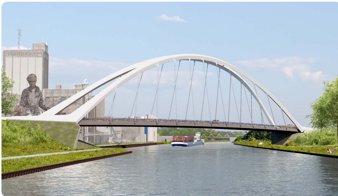
Figuur 3. Impressie van de Nettelhorsterbrug (bron: hoofdaannemer).
