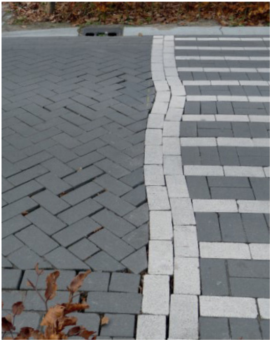
Afb. 6 Haaksheid: twee gevallen van 'niet – haaks' straatwerk. Links: is er sprake van het 'kruipen' van het 'te losse' straatwerk vanwege de verkeersbelasting. Rechts: het straatwerk is 'niet haaks' opgezet. De witte lijn geeft de haakse lijn aan en de rode lijn de afwijking ten opzichte van de haakse lijn.
