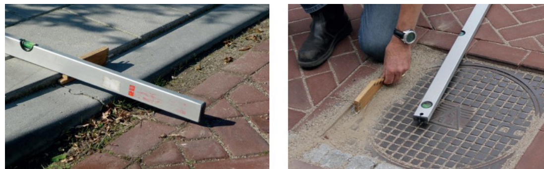
Afb. 8 Klik: twee voorbeelden van te veel uitgevoerde klik. Links: bij trottoirtegels ter plaatse van een verlaagde trottoirband. Rechts: bij een controle putdeksel in de rijbaan, waar ook fietsers rijden.
