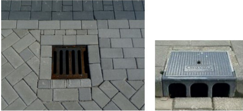
Afb. 15 Kolken: de vorm van de kolken varieert. In deze beide gevallen is te weinig aandacht besteed aan de kwaliteit van het paswerk rondom de kolken
