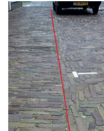
Afb. 12 Plaatsing: voorbeeld van slechte plaatsing van straatstenen. Ook de sortering op vorm, kleur en het paswerk is niet in orde (links). Verband en rechtheid van lagen: een tweetal gevallen van slecht halfsteens verband en van onvoldoende rechte lagen (rechts).
