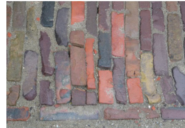
Afb. 12 Plaatsing: voorbeeld van slechte plaatsing van straatstenen. Ook de sortering op vorm, kleur en het paswerk is niet in orde (links). Verband en rechtheid van lagen: een tweetal gevallen van slecht halfsteens verband en van onvoldoende rechte lagen (rechts).
